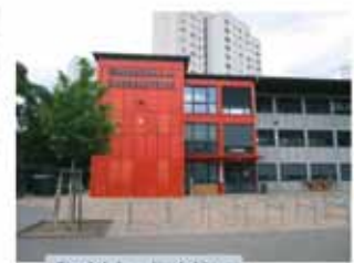
Grundschule am Humboldtring
